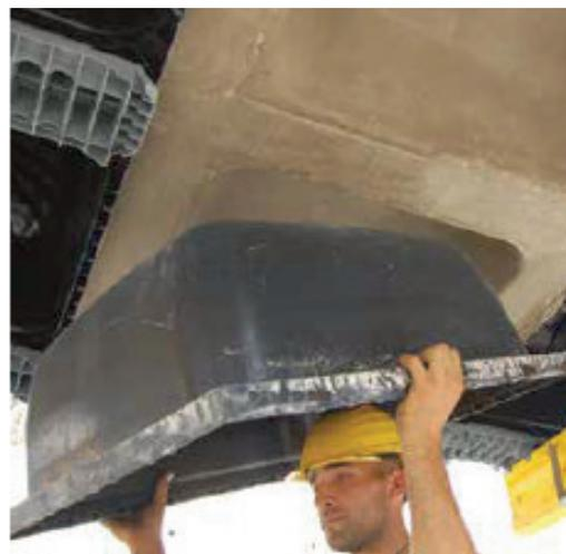
*Fase di scasseratura solaio a piastra binervata tipo Skydome*
