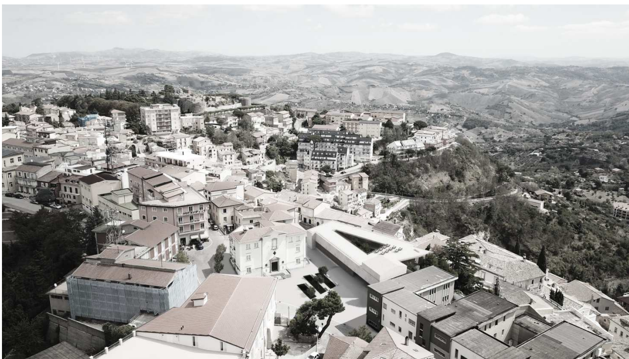
Vista esterna Prospetto Nord
