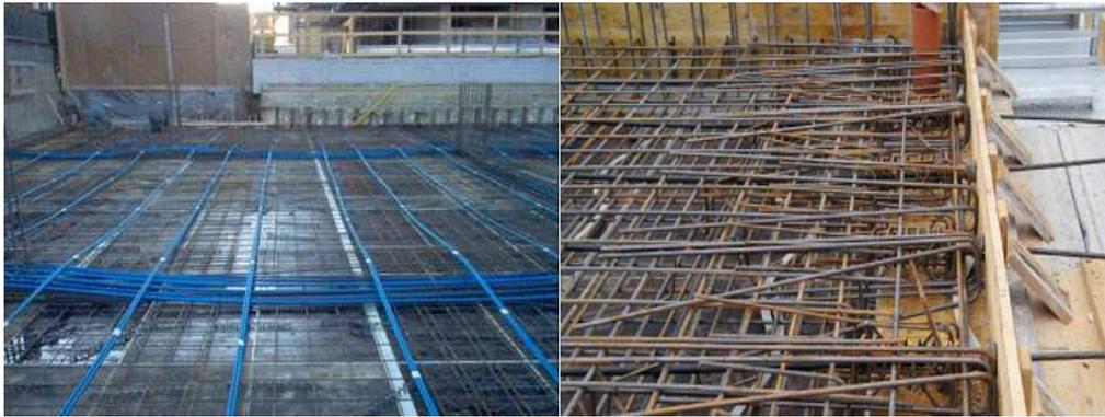
Figura 5: Solaio con cavi scorrevoli
