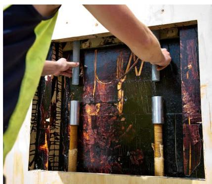
*Figura 12: Dettagli di un muro in PRESSS-Lam*
