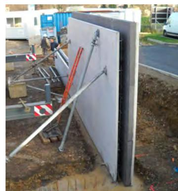
Pannelli prefabbricati a doppia lastra con isolamento termico
